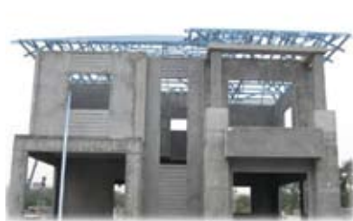
วันที่ 13 -15 ชั้นที่ 1-2 โครงสร้างเหล็ก
